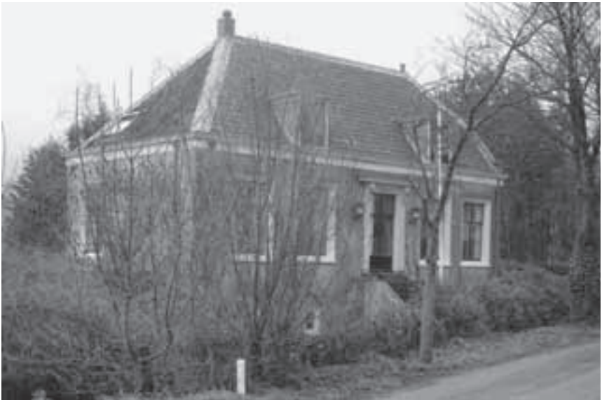
Afb.6. Middelvaart in 2005 met trap aan de straatgevel (Foto W.M. Timmer).
