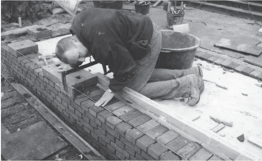
Afb. 4. De hardstenen blokken waarin het hek komt te staan worden secuur op hun plaats gesteld.
