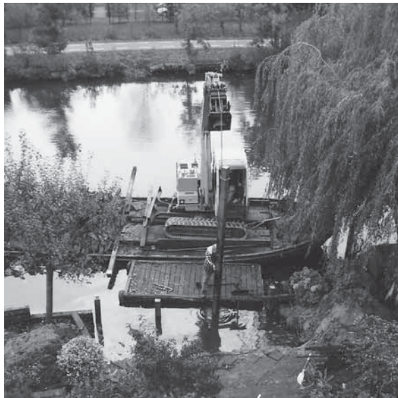
Afb. 1. Palen worden in de oever gedreven vanaf een werkboot.
