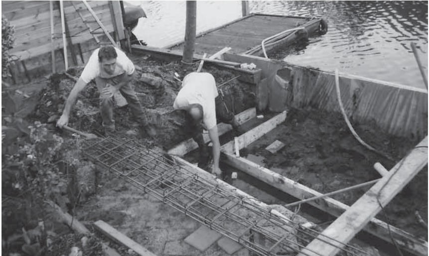
Afb. 2. Een betonbekisting wordt op de palen aangebracht.
