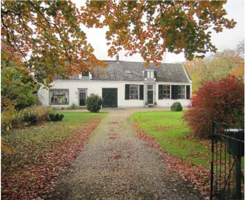
Afb. 26. Het linkerdeel met koetshuis bewoond door de familie Schoenmaker, het rechterdeel door de familie Kotting. (Foto: auteur 2012)
