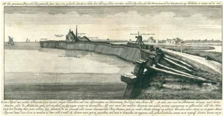
Afb. 4. De Diemerzeedijk moest het door inklink steeds lager liggende land beschermen tegen de Zuiderzee. Na de storm en de overstroming van juni 1705 werd deze prent van 'De slechte toestand van de Diemerdijk vanaf Diemen tot aan Jaap Hannes' gemaakt om daar aandacht voor te vragen en voor de kwetsbaarheid van het achter de dijk gelegen land. De palen zijn door de paalworm aangevreten en het land achter de dijk ligt zo laag, dat de uitwaterende sluis (achter de gebouwtjes) alleen bij laag water opengezet kon worden om het water uit de achterliggende polder te lozen. (Coll. Rijksmuseum)
