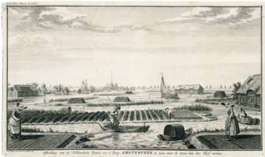
Afb. 9. Dit zicht op Amsterveen (1741) toont de verschillende stappen in de natte verving (of slag-turven) en de aanslag daarvan op het landschap. In het midden wordt de specie met de baggerbeugel opgegraven en in de boot gehaald. Vervolgens op de legakkers te drogen gelegd en tot turven gestoken, die dan te drogen worden gezet. (Bron: http://www.geheugenvannederland.nl/?/nl/items/ZZM01:002866 )
