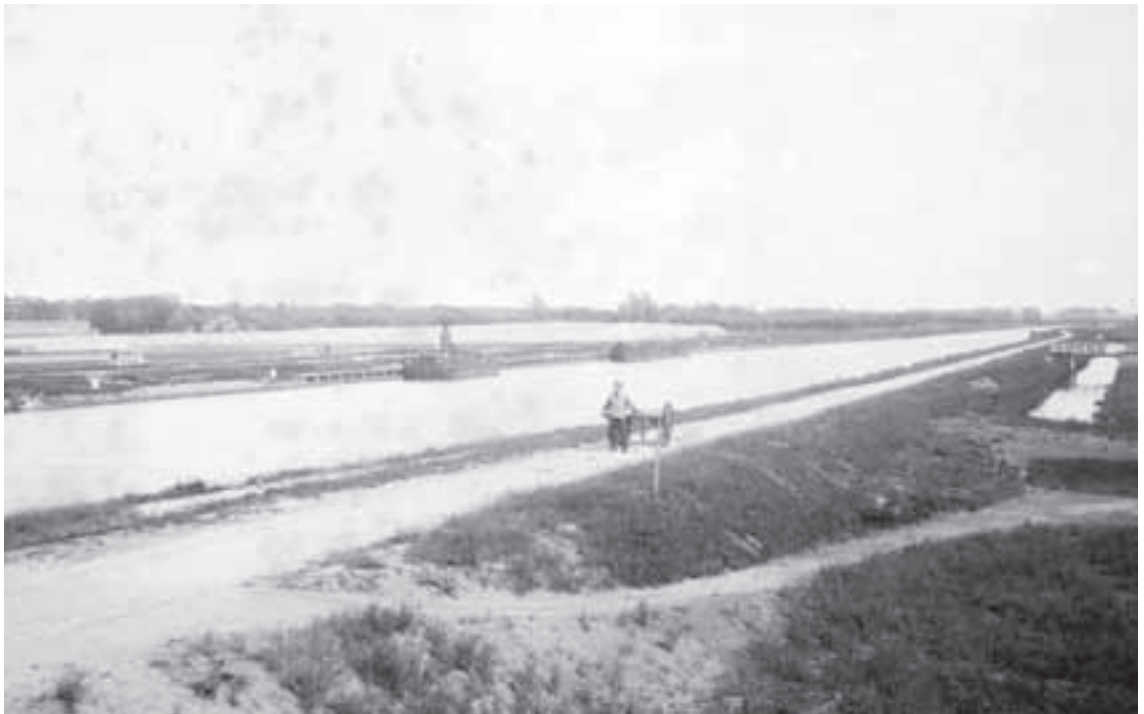
Afb. 56. Het kanaal is klaar, alle werkzaamheden zijn uitgevoerd, de opening kan plaats vinden.
