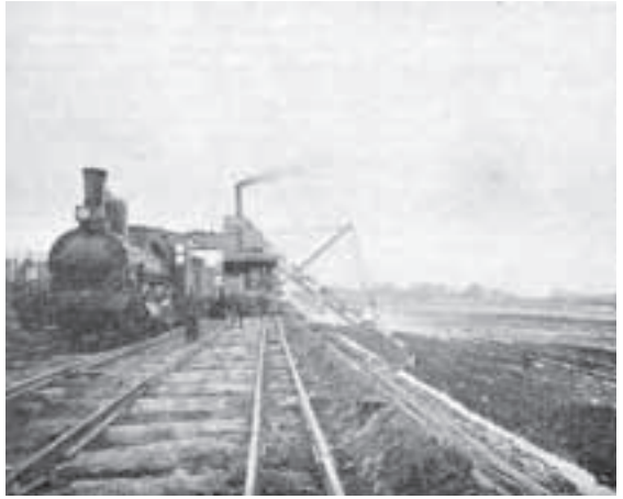
Afb. 23. Een excavator die werd ingezet om de taluds te realiseren.
