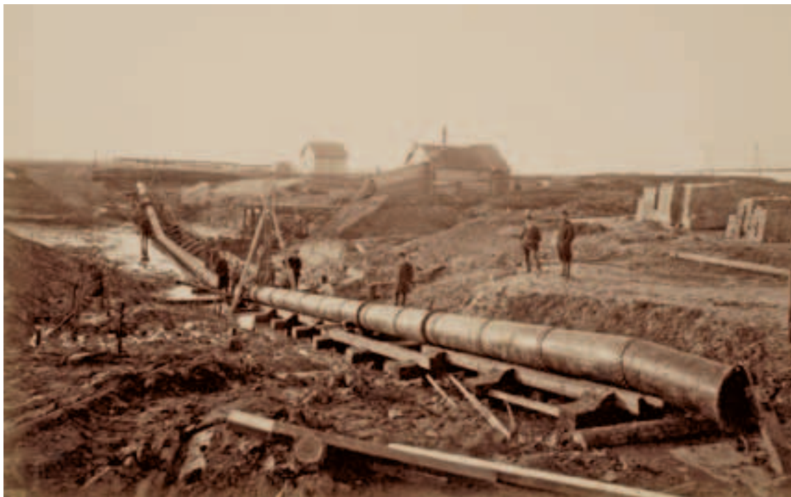
Afb. 27. Werkzaamheden aan een grondduiker. (Locatie onbekend)
