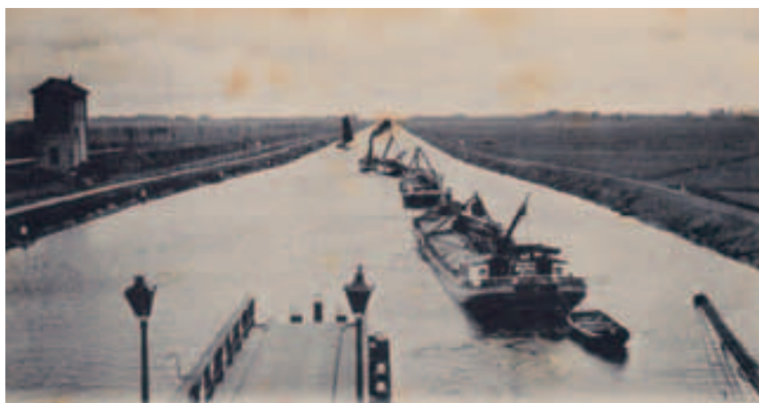
Afb. 60. Geopende draaibrug bij Nieuwersluis. (Coll. W. Mooij)
