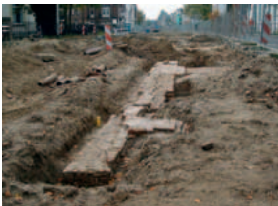
Afb. 15. Op de plaats waar de Vecht de Biltstraat in Utrecht kruiste lag vroeger de Gildbrug waarvan resten bij werkzaamheden in 2000 tevoorschijn kwamen. (Foto: L. van der Tuuk)
