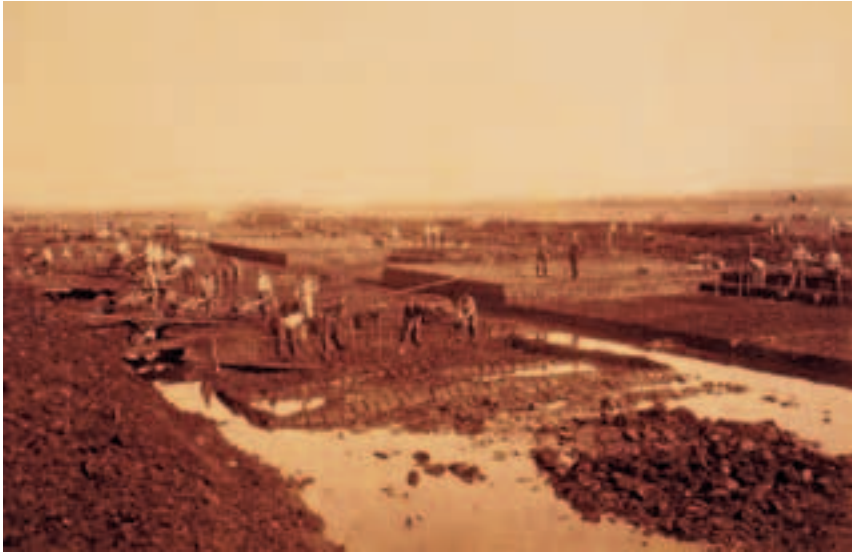
Afb. 21. Graafwerkzaamheden, met de schep en kruitwagens, ter hoogte van Breukelen, op de achtergrond de kerktorens van de RK en de Hervormde kerk. 22 mei 1889. (Coll. Vechtstreekmuseum)
