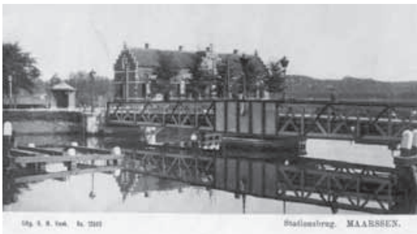
Afb. 42. De brug in Maarssen, geheel links de Stationsweg; in het midden de woningen van de brugwachter en zijn knecht en daarvoor het schuilhuisje. (Coll. H.K. Maarssen)
