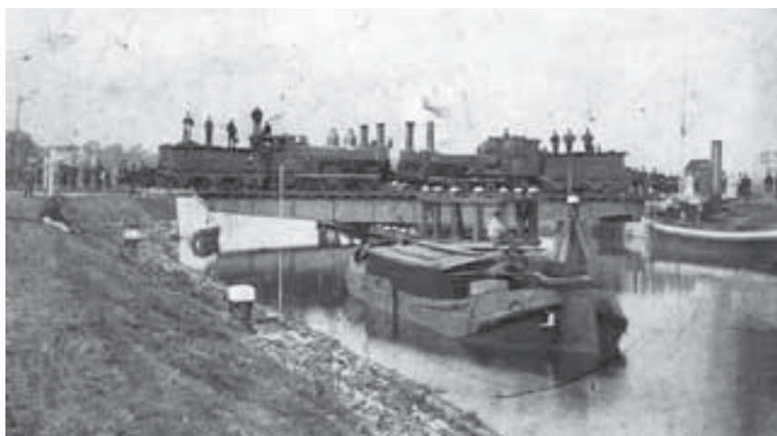
Afb. 40. Het testen van de spoorbruggen met vier zware locomotieven. Vaste spoorbruggen lagen bij Weesp en twee in Utrecht.
