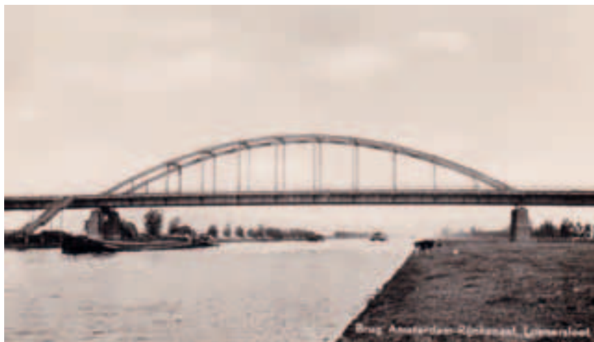
Afb. 46a. De vaste brug die sinds 1938 de draaibrug bij Loenersloot verving. De rechter pijler staat sinds de verbreding van het kanaal in 1952 in het water. (Coll. W. Mooij)
