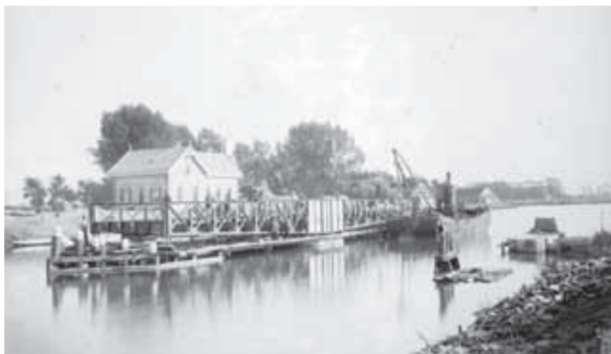
Afb. 39. Een draaibrug in aanbouw. (Locatie onbekend)
