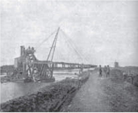
Afb. 22. Een traditionele baggermolen wordt ingezet bij het ontgronden.
