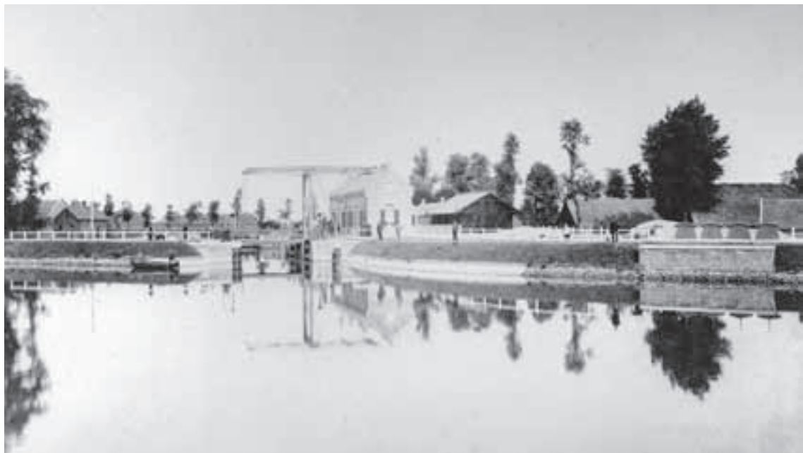
Afb. 33. Zicht op de ophaalbrug in de Rijksstraatweg, links het kanaal; rechts de dubbele sluiswachterwoning met daarnaast de schotbalkloods. Op de voorgrond de vier afsluiters voor de grondduikers van de Proostwetering. Het huis midden in de foto zou het inmiddels afgebroken huis Kattenburg of Ruimzicht kunnen zijn. (Foto 6 september 1892)
