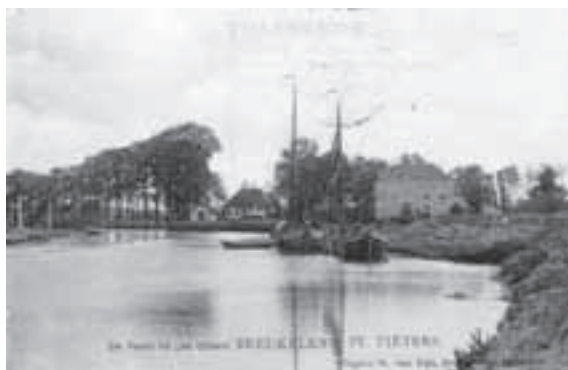
Afb. 5. Een Keulenaar ligt afgemeerd bij de steenfabriek Vecht en Rhijn op de grens van Breukelen en Maarssen. Let op de rolpalen, alleen al in deze bocht 8 stuks, die de jaaglijn verhinderen over de weg te slieren. (Coll. Van Bommel)
