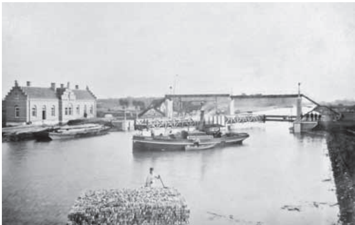
Afb. 38. De draaibrug en de hoge voetbrug bij Nieuwersluis op 22 september 1891. Een van de overspanningen van de voetbrug is geplaatst op jukken die opgericht zijn op twee gekoppelde vaartuigen, zodat deze tijdelijk opzij gevaren kan worden om doortocht te verlenen aan een baggermolen met transporteur. Let op het vlot met gestapelde bakstenen op de voorgrond. (Coll. HUA)
