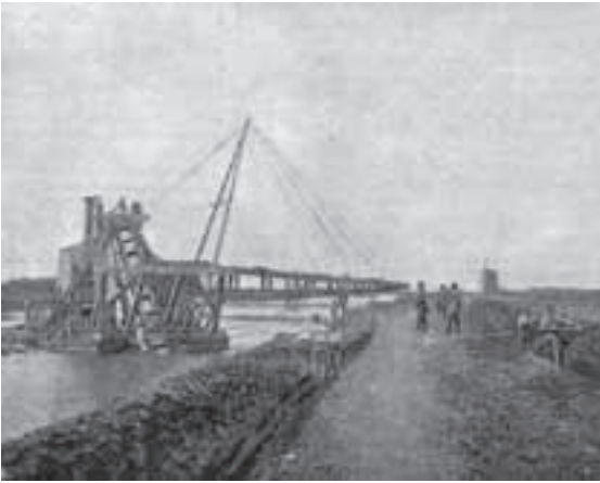
Afb. 24. Een elevator voert de gebaggerde grond omhoog om de dijk op te hogen.
