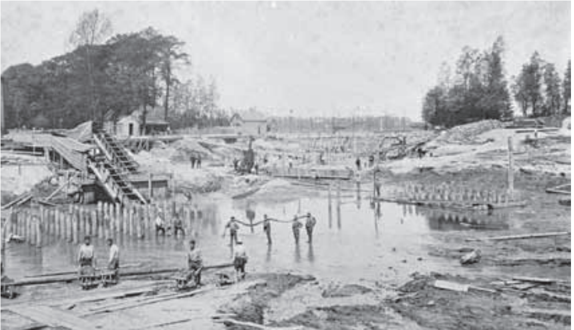
Afb. 31. In deze 1.5 hectare grote bouwput zijn in aanbouw twee schutsluizen, een grondduiker van vier kokers en een vaste brug. Op de achtergrond is nog een rolpaal langs de Vecht zichtbaar. (16 mei 1890 vanaf de Westkanaaldijk, Coll. HUA)
